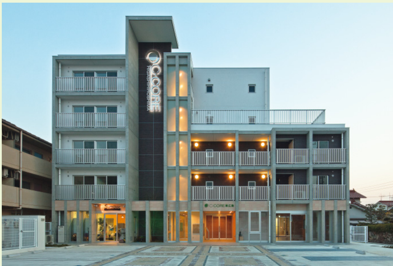
地域貢献型多世代賃貸住宅「C-CORE東広島」の外観
